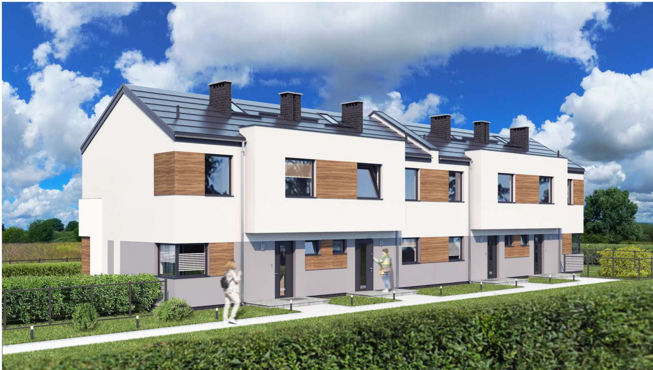
BUDYNEK 4-LOKALOWY W MOSTACH PRZY UL. MORWOWEJ
